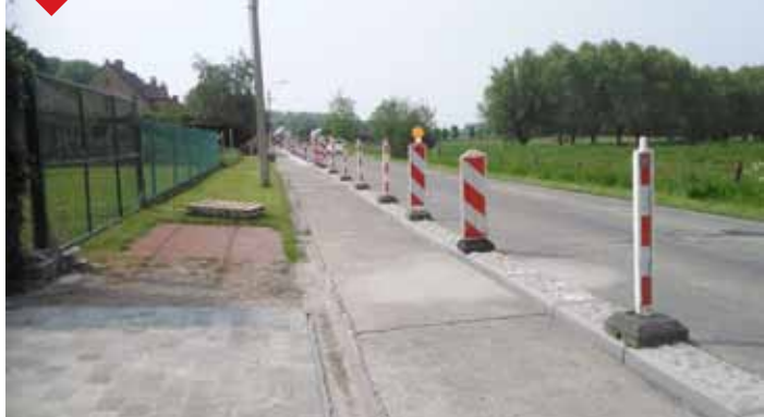
Ribbelstrook Stadenstraat: de ribbelstrook in de Stadenstraat werd aangelegd tot de Kasteeldreef. Na het bouwverlof wordt het fietspad vanaf de Kasteeldreef volledig vernieuwd.
