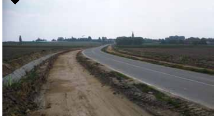
Fietspad Esenstraat: alle grachten werden aangelegd tot in Esen. Momenteel is men bezig met de aanleg van het fietspad zelf.
