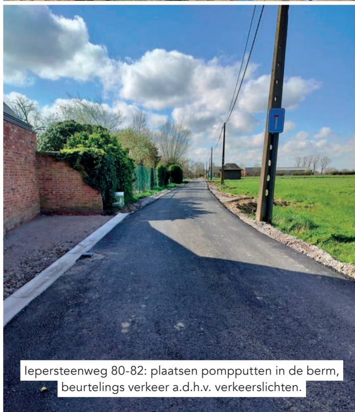
Steenbeekstraat: nutswerken in het voet- en fietspad (tot aan het bouwverlof)
