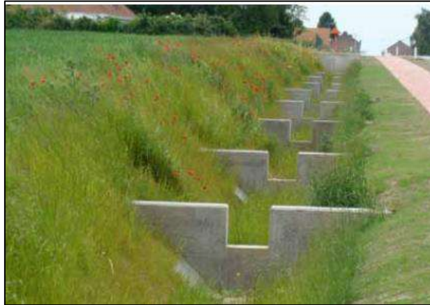
Figuur 102: Gracht met stuwconstructies (Vlaamse Overheid, 2010)
