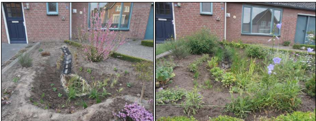
Figuur 86: Regenwater naar wadi in voortuin (links: aanleg wadi, rechts: wadi voltooid) (Van Eck, G., sd)
