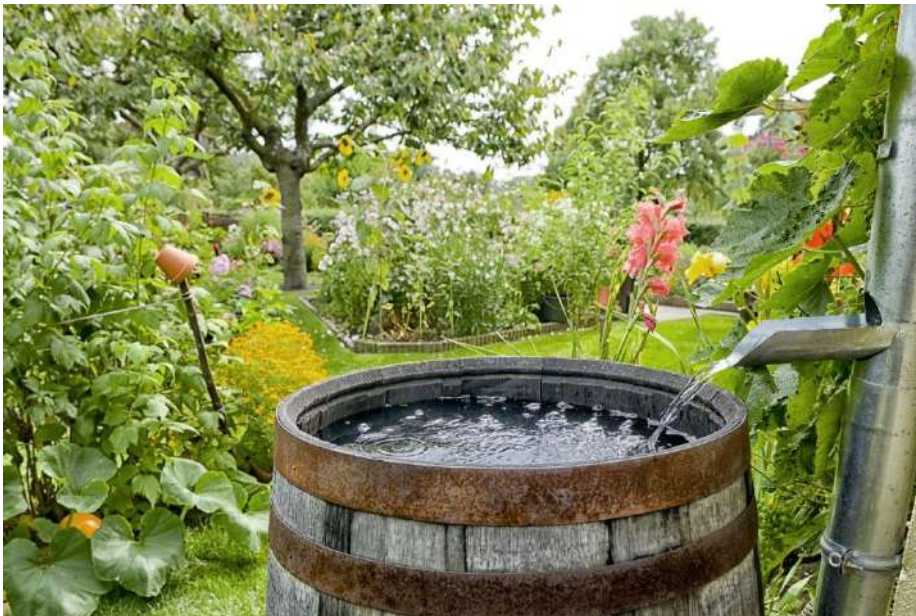
Figuur 89: Regenwaterton voor opvang en hergebruik van regenwater
