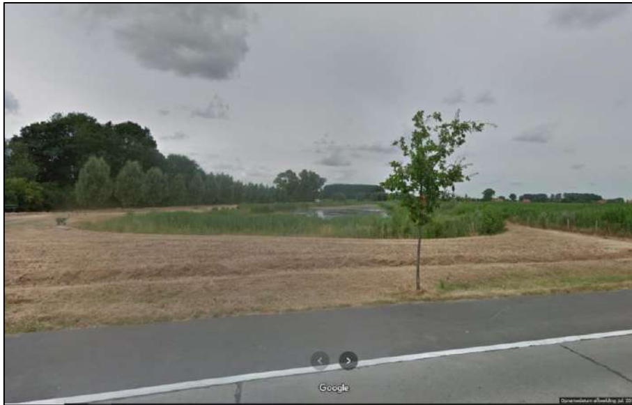
Figuur 100: Bufferbekken en GOG aan de Moorsledestraat, Moorslede (Google, 2022)
