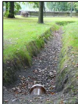
Figuur 96: Infiltratiegracht (Waterbewust bouwen, 2022))
