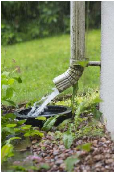
Figuur 88: Afkoppelen dakafvoer van het afvoerstelsel
